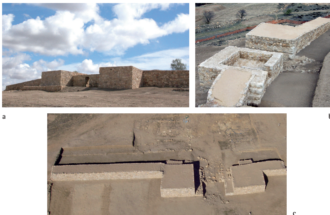
Figura 6. La muralla tardorrepblicana: a. Puerta Norte; b. Puerta Noroeste; c. Puerta Sur
