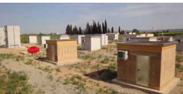
Instal·lació de la UdL per avaluar els comportaments dels materials de construcció i energia.
